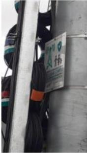
Señalización: Solo una de las antenas ubicada en la terraza cuenta con señalización (de difícil observación) donde se indica la presencia de radiación electromagnética
